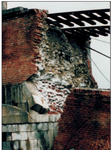
Sopra, muratura di riempimento del viadotto sul fiume Gesso della tratta Cuneo-Mondovì, crollato con l'alluvione del 2001
